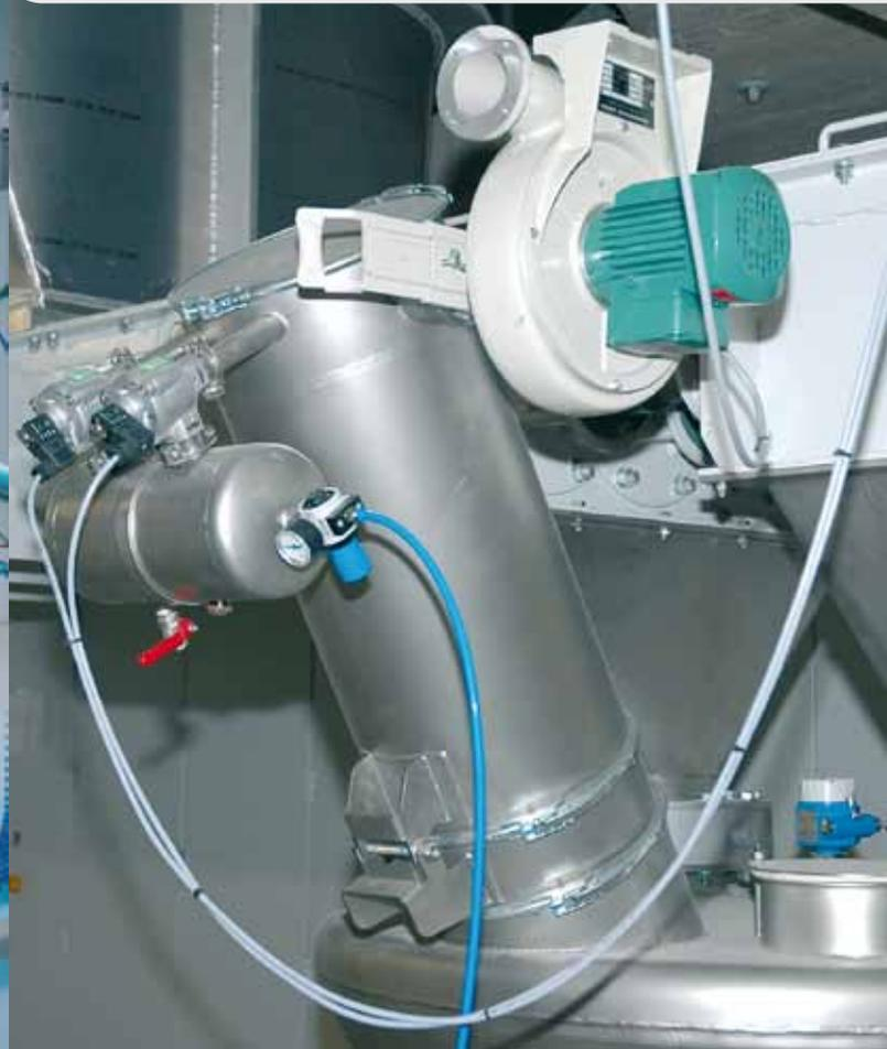
Bei pneumatischen Förderungen muss am Ende der Förderung die Luft wieder vom transportierten Produkt getrennt werden.
