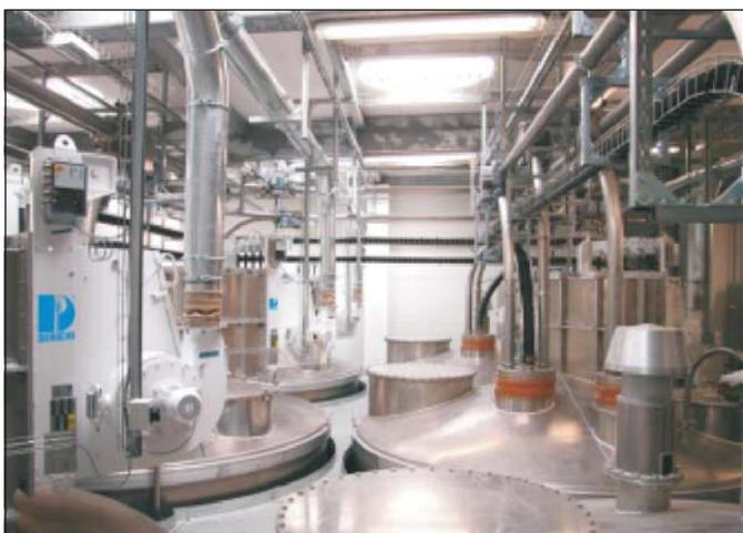
Siloköpfe mit Füll- und Entstaubungssystem
